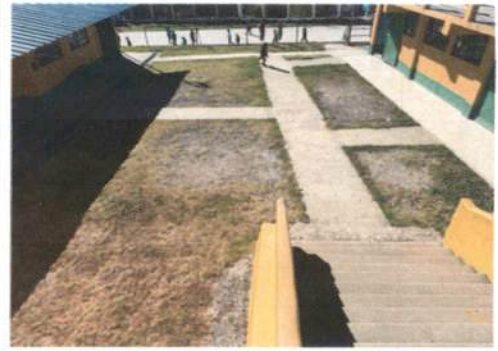
Foto 4: 6 PISO (6.1 Reparación de piso de torta de concreto )
