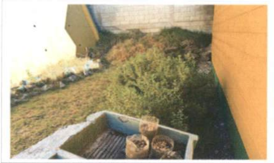
Foto 3: 14 RED DE DRENAJE (14.4 Sustitución de tubería pvc línea principal aguas pluviales)
