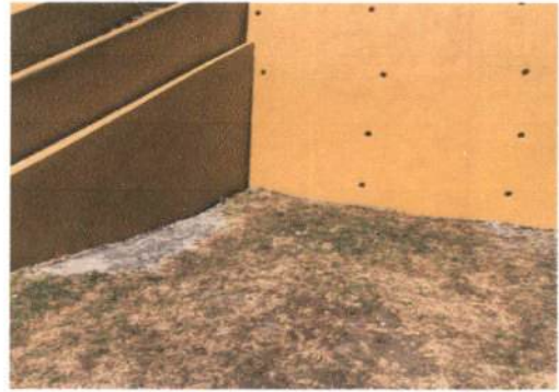
Foto 2: 6 PISO (6.1 Reparación de piso de torta de concreto )
