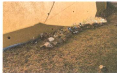
Foto 6: 14.8 Sustitución de cajas de registro
