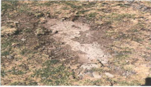
Foto 1: 6 PISO (6.1 Reparación de piso de torta de concreto )
